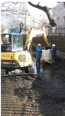
厳寒の中、トンバッグ(大型土嚢)500袋以上を使い、周りを汚染させぬよう汚泥の水分をしっかりと抜いた上で搬出。
