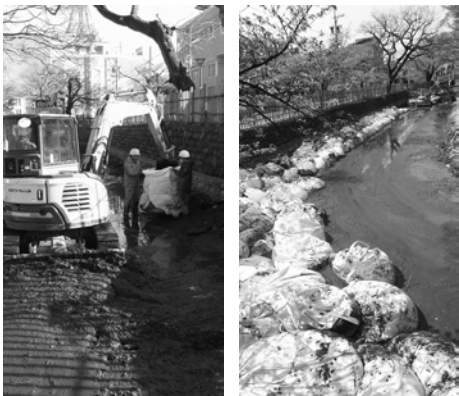
厳寒の中、トンバッグ(大型土嚢)500袋以上を使い、周りを汚染させぬよう汚泥の水分をしっかりと抜いた上で搬出。
