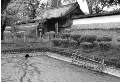
浚渫前。汚泥がおよそ現在の水面の高さまで堆積していました。(2019年5月)
