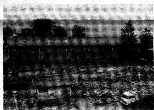
講堂の撤去跡、手前の土蔵は既に移動済み
