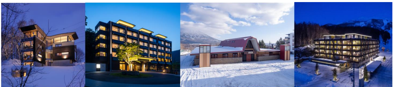
■ ニセコの作品群 ヒラフ中心地区に12の建築が実現しています。クライアントはほとんどが外国の方です。
