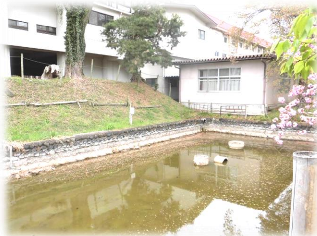
水位が1メートル以上下がった、お堀北側
