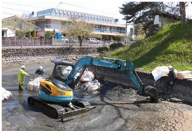
お堀の浚渫工事・後方は同窓会館（2020年4月）
